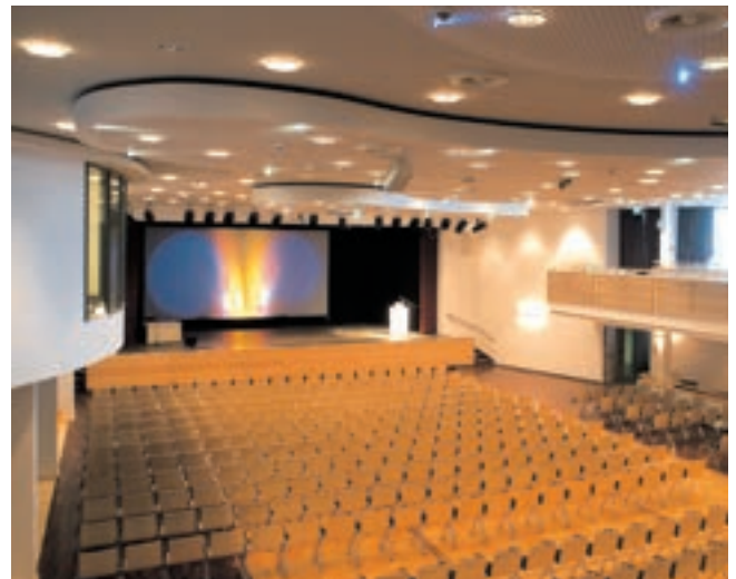
Die Deckenbeleuchtung des CCS, vor allem in den Sälen „Westerland“ und „Frisia“, wurde bereits 2018/2019 auf LED-Technik umgerüstet.
