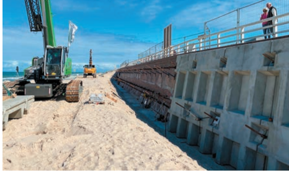
Montage der Wandfertigteile vor dem Altbestand der Ufermauer in 2021
