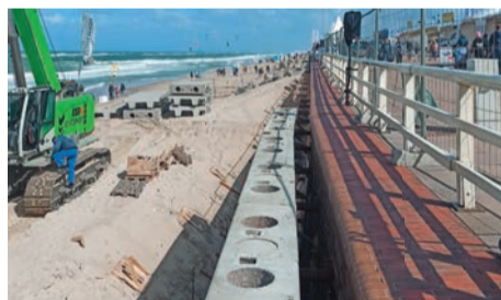
Die Wandkopffertigteile werden in die dafür vorgesehenen Löcher eingesetzt.
