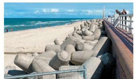
Die zum Teil gebrochenen Tetrapoden vor der dem Altbestand der Uferwand werden 2022 abtransportiert.
