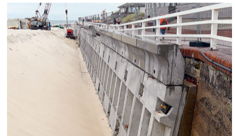
Arbeiten in 2019, Installation der Wandfertigteilelemente im Abschnitt 6
